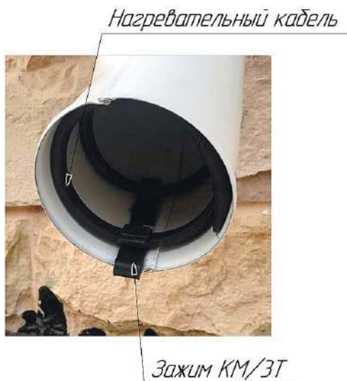
Рис. 4 (Крепление нагревательного кабеля с использованием зажима КМ/ЗТ, сливное колено)
